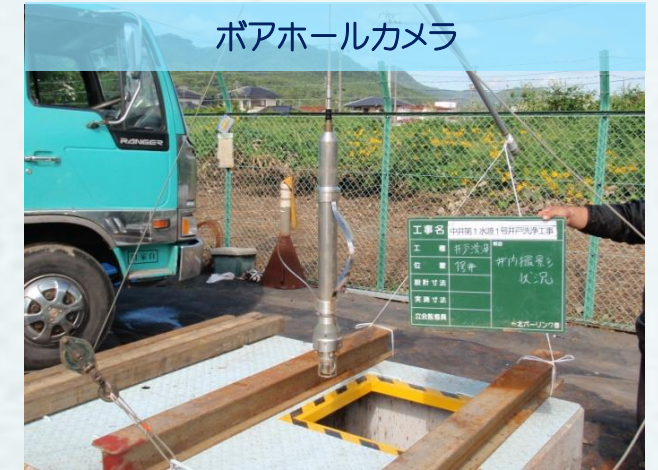
井戸掘削工事
