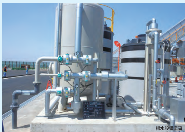
揚水設備工事
